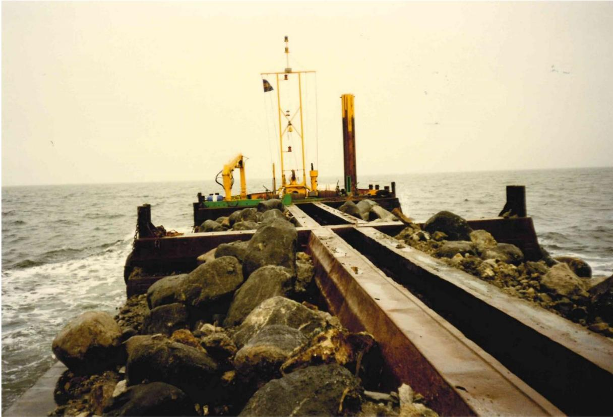
**Abb. 2:** Steinstürzer bei der Verklappung der Natursteine.
