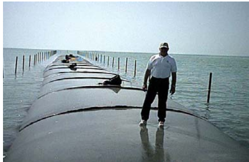
Abb. 6 Geoschläuche in der praktischen Anwendung (A - „Amwaj Island“) und Umschließungsbauwerk aus Geoschlauch und Steinschüttung (B - Prinzipskizze), Quelle: KNAACK 2004
